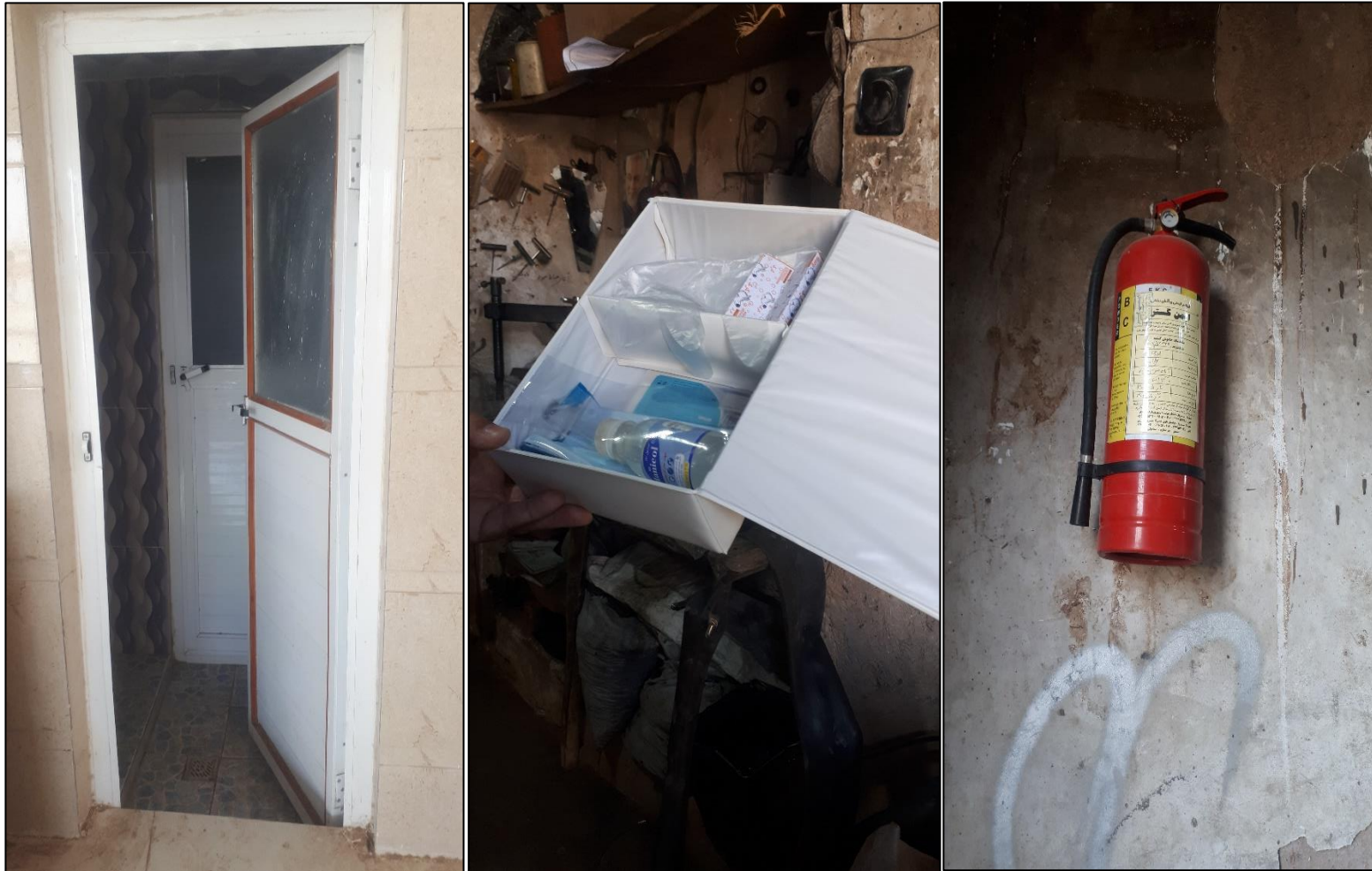
ایجاد سرویس بهداشتی / نصب کپسول اطفاء حریق و جعبه کمک های اولیه
