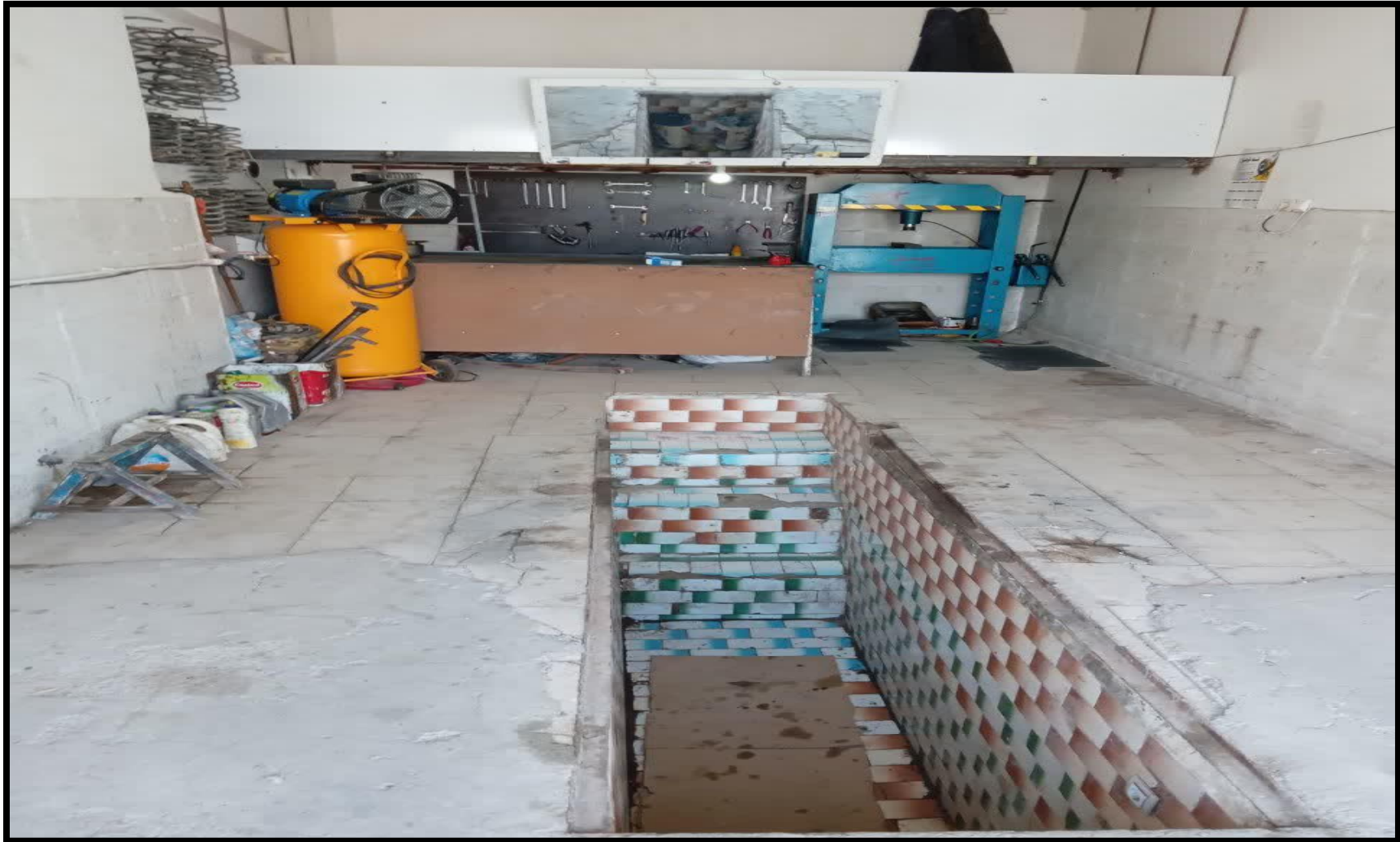
اصلاح روشنایی و بهسازی ساختمانی در کارگاه جلوگیری از آلودگی - سلطان آباد
