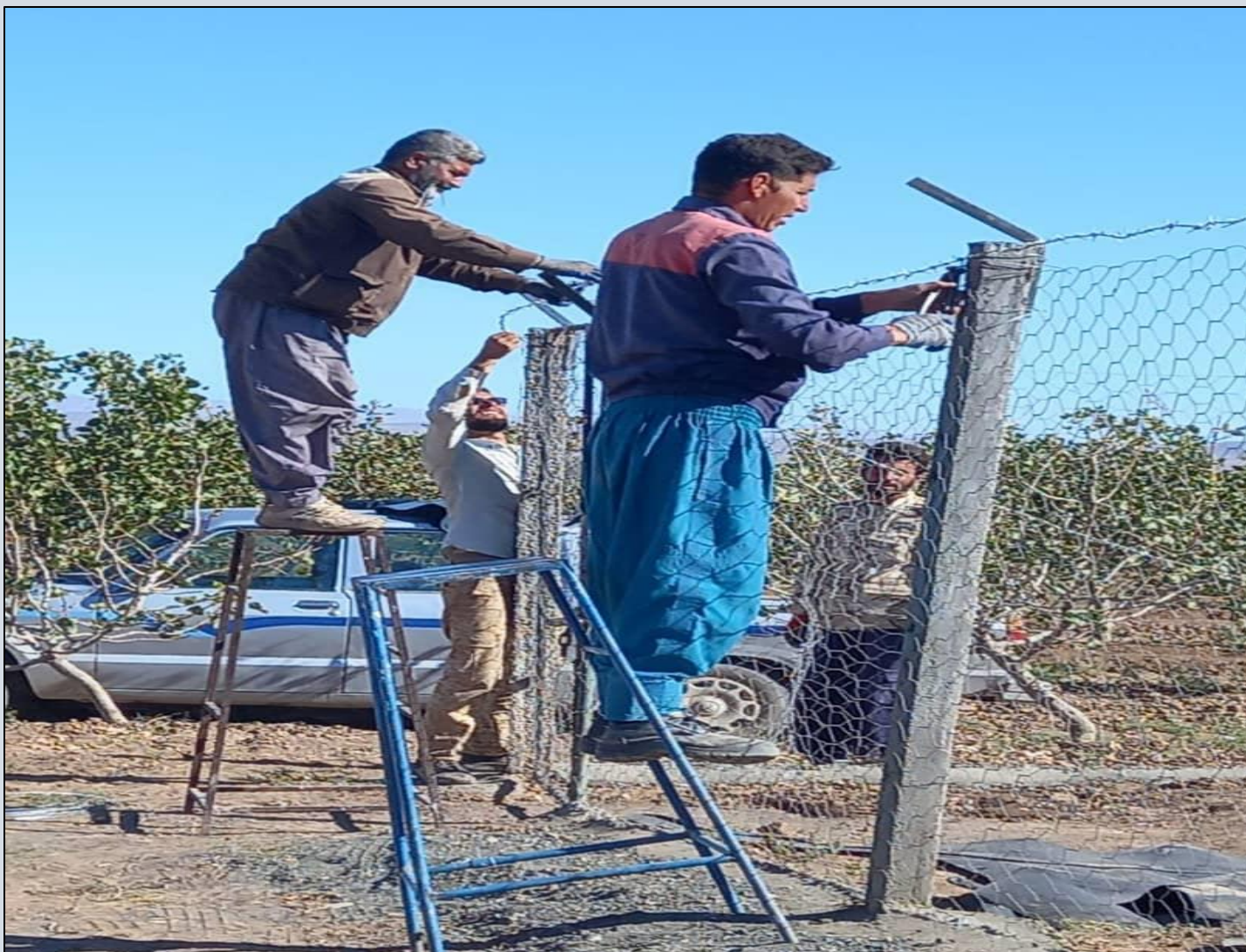
نصب و تعمیرات توری سیمی (فنس) و نصب سیم خاردار
